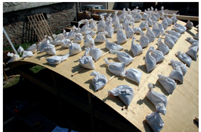
Abb. 6: Belastungsversuch mittels Sandsäcke ( F = 0,3 \text{ kN} ) am Demonstrator eines in Segmenten vorgefertigten Zollingerdaches auf der Baustelle
