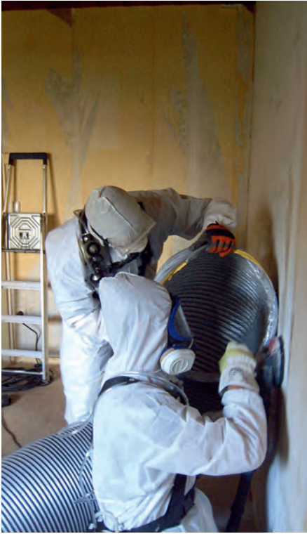
Abb. 2: Abtrag von schimmelpilzbelastetem Putz mit abgesaugtem Bearbeitungssystem und Einsatz eines Luftreinigers
