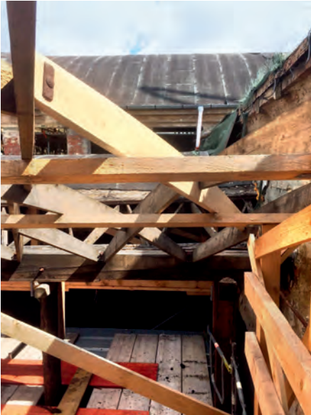
Abb. 8: Die Hölzer werden in einem exaktem Winkel zueinander angeordnet
