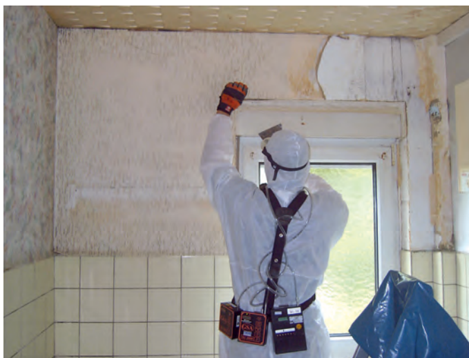
Abb. 4: Messtechnische Begleitung der Tätigkeiten – Abtrag Tapete
