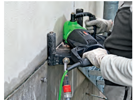
Abb. 2: Trennschleifer von Abbildung 1 betrieben mit Wasserniederschlagung der Stäube (Foto: Eibenstock)
