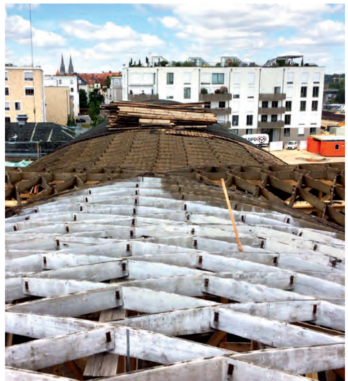
Abb. 1: Von Juni 2015 bis Oktober 2017 wurde das Zollingerdach saniert
