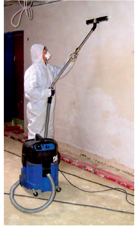
Abb. 3: Feinreinigung des Sanierungsbereiches
