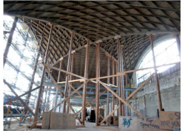
Abb. 9: Abgestützte Partie des Zollingerdaches mit seiner typischen Rautenstruktur (Foto: Firma Bennert)
